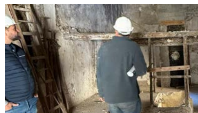
Chantier de réhabilitation lourde d'un îlot à Carpentras
